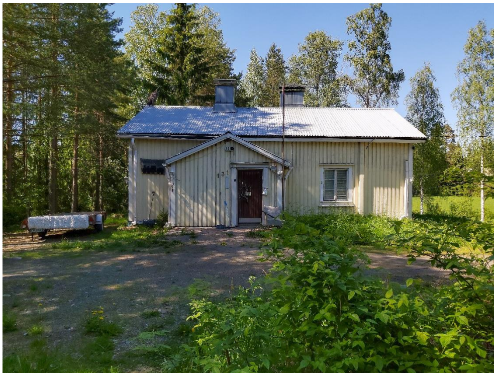
Kuva rakennuksesta katuosoitteessa Virtalantie 131
